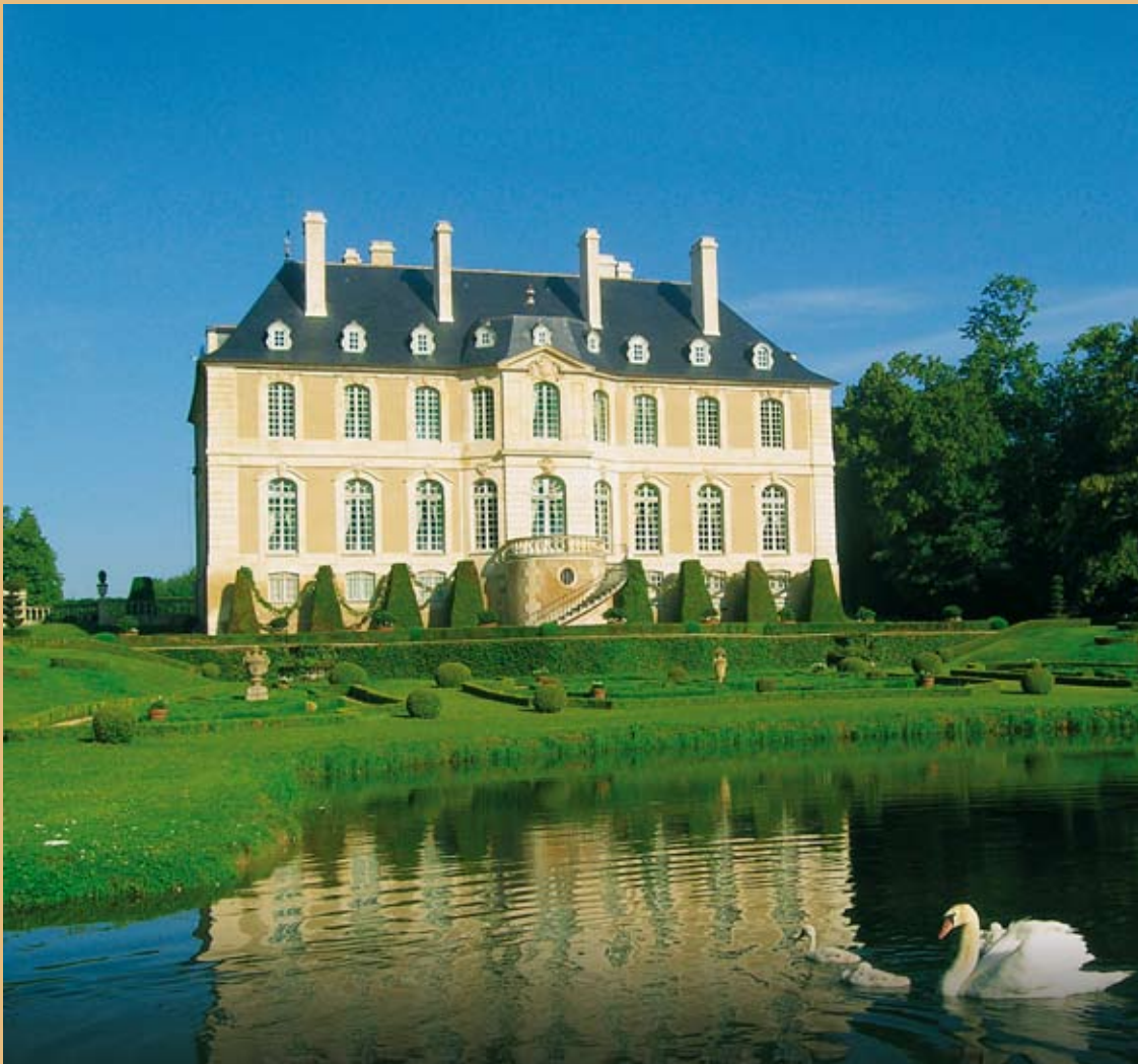
Vue de la façade arrière du Château
